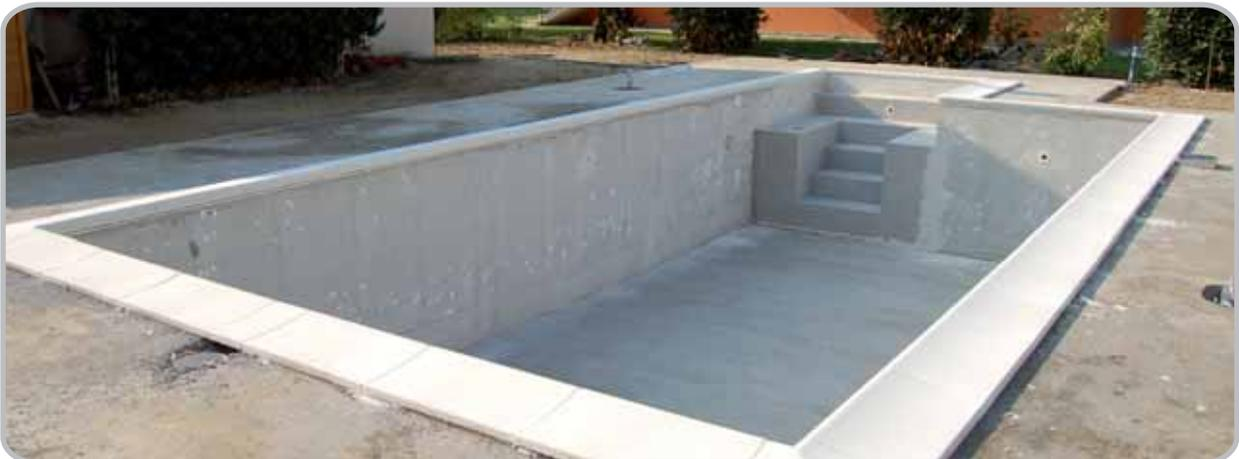
Die hohe Qualität des Gusses limitiert das mühevollen Glätten, auf nur wenige Details. Das Verlegen des Liner wird direkt auf der Betonwand ausgeführt, so vermeidet man das Anbringen von Schutzpolstern. Vorgefertigte Treppen in allen beliebigen Formen können schnell eingesetzt werden.
