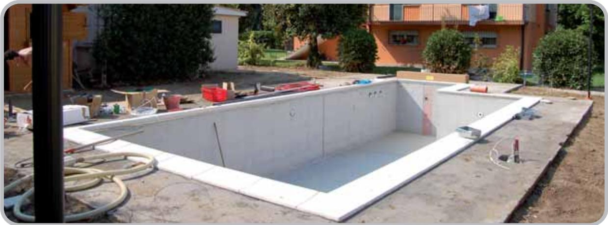
Die extreme Anpassungsfähigkeit von **GEOPANEL®** ermöglicht den Bau von Wannen, mit Anlagen und Zubehör, die bereits im Guss vorbereitet wurden, somit erspart man sich Demolitionsarbeiten.
