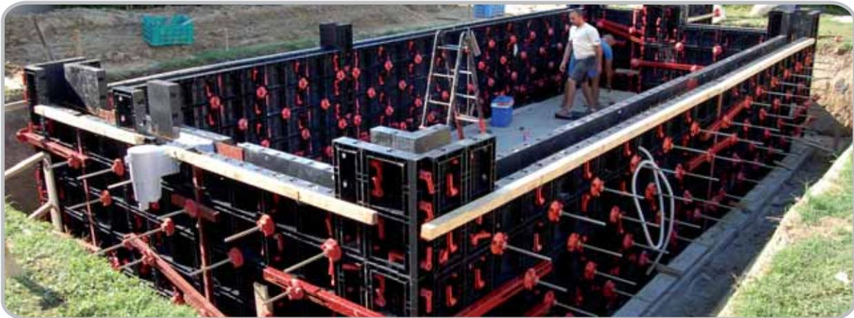
Dank der Modularität von **GEOPANEL**® kann man Schalungen schnell für den Guss von Wannen in beliebigen Formen und Größen herstellen. Die Nutzung schädigt weder Parks noch Gärten. Der Arbeitsbereich ist umschrieben, somit wird die Integrität der Grasfläche garantiert.
