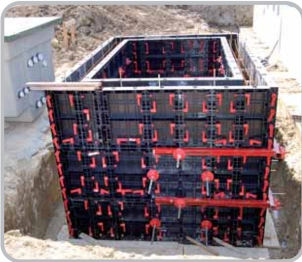
Dank des Angebots von speziellen, sowie auch von Kompensations-Paneelen kann man durch die Kombination der Elemente rechte Winkel, T-, oder Kreuzwinkel herstellen.
