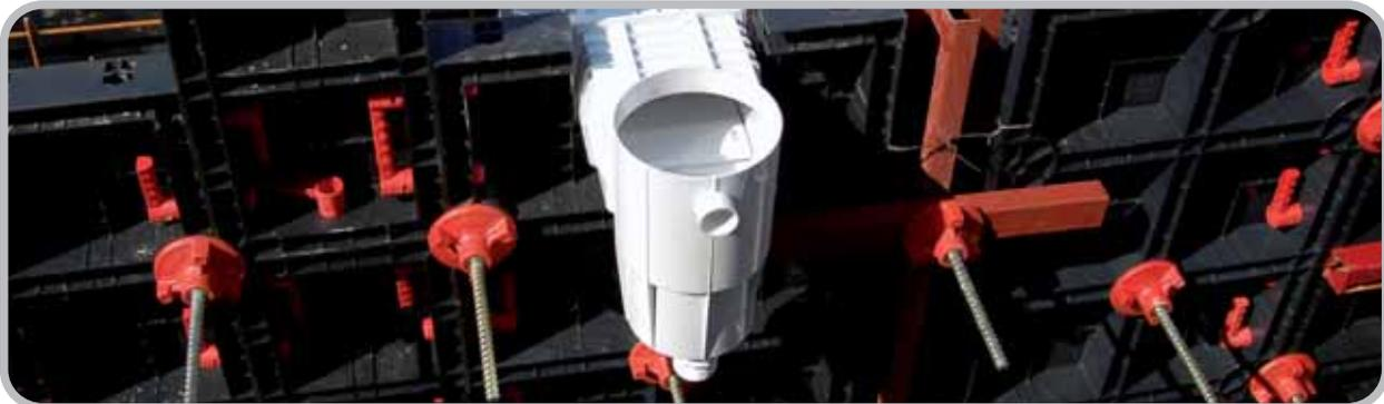
Mit angemessener und korrekter Fassonierarbeit ist es möglich, mit Stahlschrauben, an dem Peneel, die Lichter, den Skimmer und andere Zubehörteile einzuhaken, die in den Guss einverleibt werden. Man kann in dem Guss auch unterschiedlich große PVC Rohre positionieren, um die Anlagentechnik verlegen zu können.
