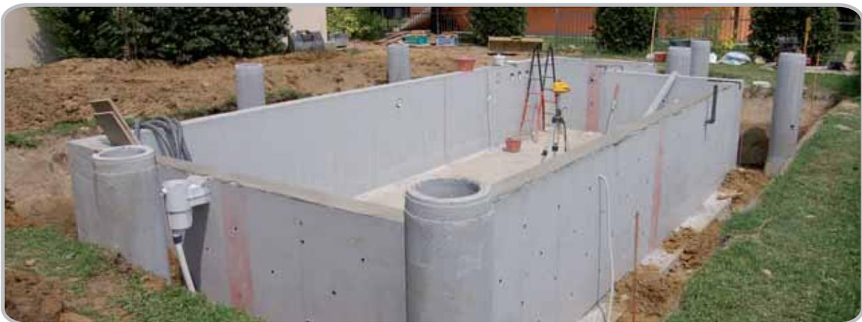
Der mechanische Widerstand des **GEOPANEL**® Panels beschleunigt den Guss und lässt eine angemessene Vibration des Betons zu. Die Gussoberfläche wird somit völlig glatt. Nach dem Aushärten, kann die Entschalung der Paneele schnell und ohne Schwierigkeiten vorgenommen werden. Die Paneele können schnell mit Wasser und ohne Reinigungsmittel gereinigt werden.
