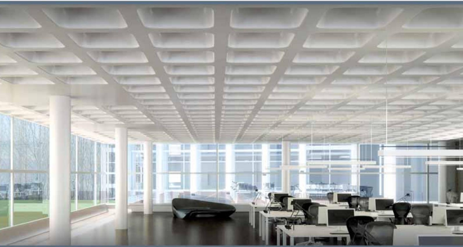
Zweiachsige Stahlbeton- Kassettendecken für große Spannweiten
