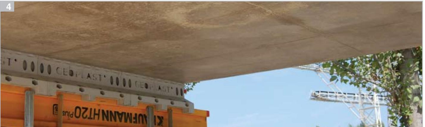
Die Y-Träger bleiben in Position bis zur vollen Verhärtung des Betons
